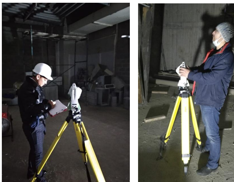
Рисунок 42 - Замеры вертикальных перемещений перекрытия тахеометром «Leica Flexline TS02plus»
