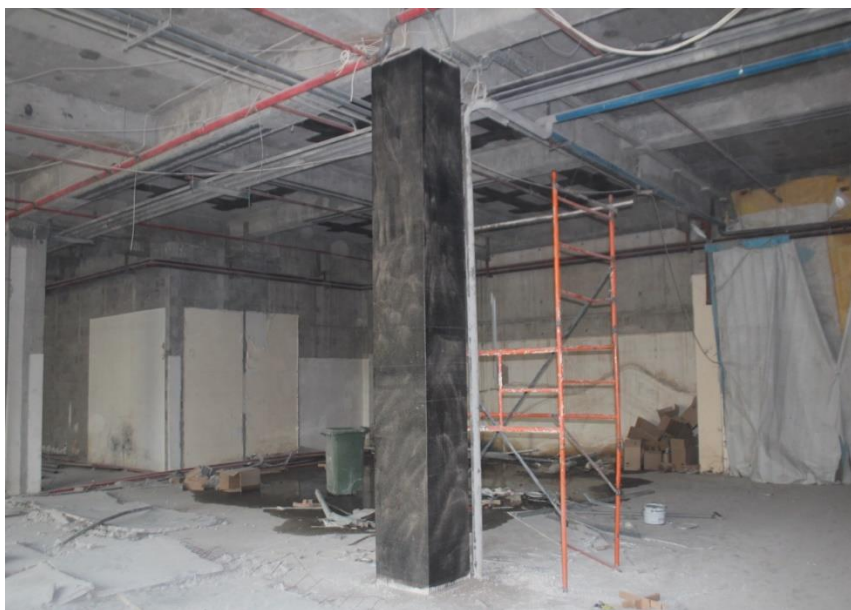
Рисунок 46 - Усиление колонны Блок 1 (Павильон 1)
