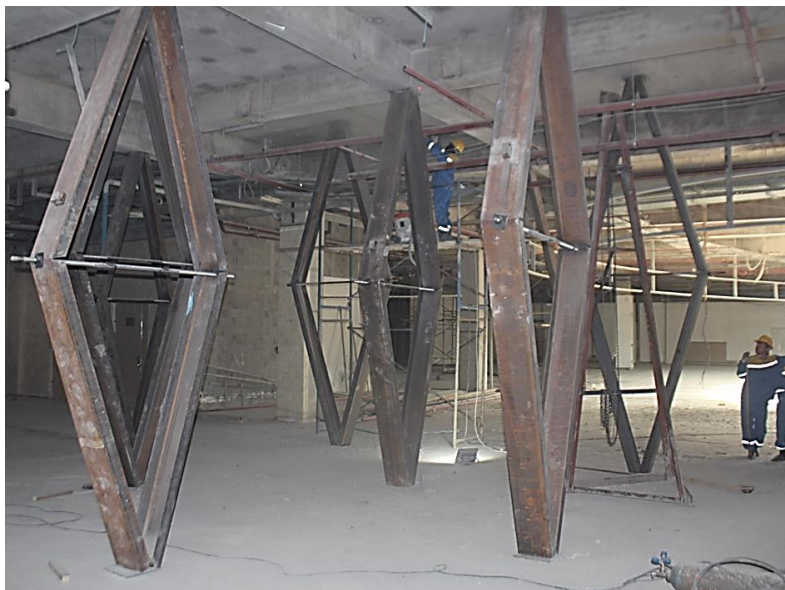
Рисунок 47 - Вид телескопических стоек для подъема перекрытий
