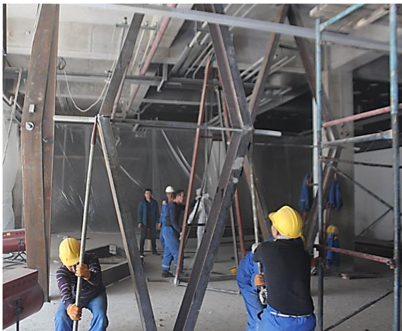
Рисунок 49 - Опускание телескопической опоры раскручиванием гаек стяжного болта
